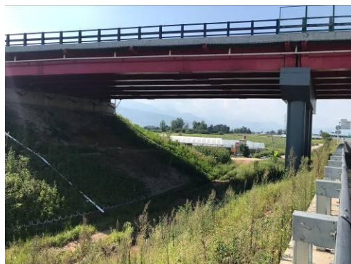
桥梁工程边坡绿化（2020年9月）
