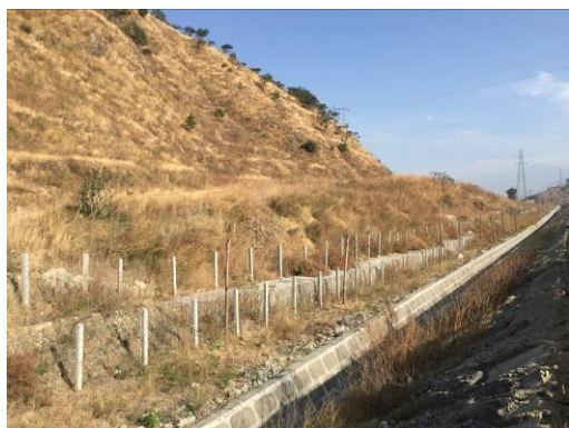
弃渣场植被恢复（2018年2月）
