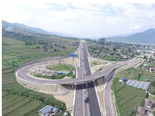
互通工程区建设（2018年8月）
