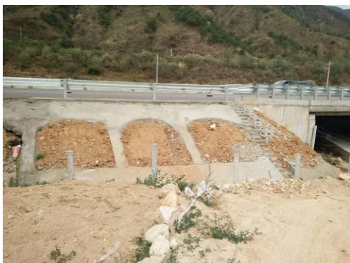
TJ 标路基工程边坡防护（2018 年 5 月）
