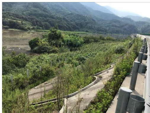
TJ 标路基工程边坡绿化（2020 年 9 月）
