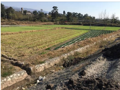
TJ3 路基工程边坡填筑（2018 年 9 月）
