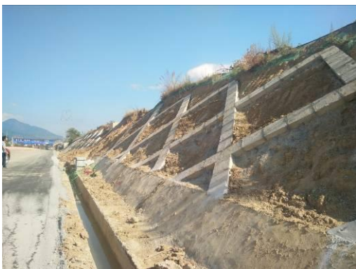
TJ1 路基工程框格网护坡（2018 年 9 月）
