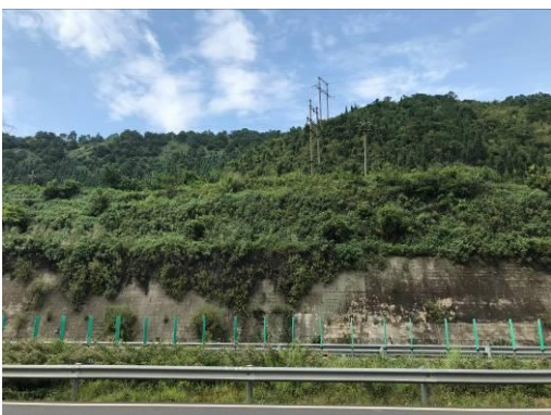
路基工程边坡植草（2020 年 9 月）
