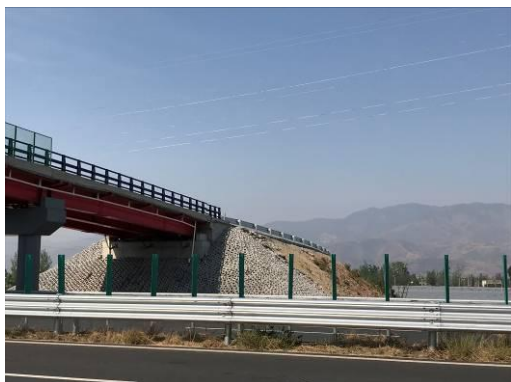
桥梁工程边坡防护（2020年4月）
