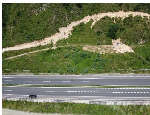
弃渣场植被恢复（2020年9月）
