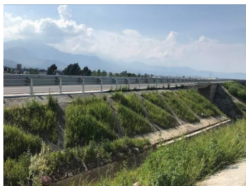
互通工程区骨架护坡植被（2020年9月）
