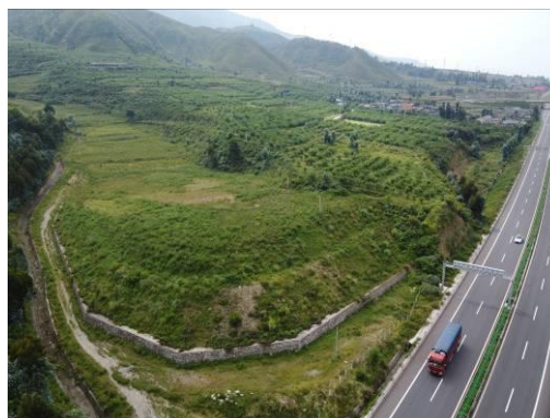
弃渣场植被恢复（2020年9月）
