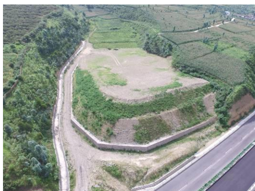
弃渣场植被恢复（2018年8月）
