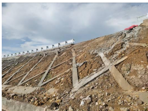
互通工程区骨架护坡（2019年7月）
