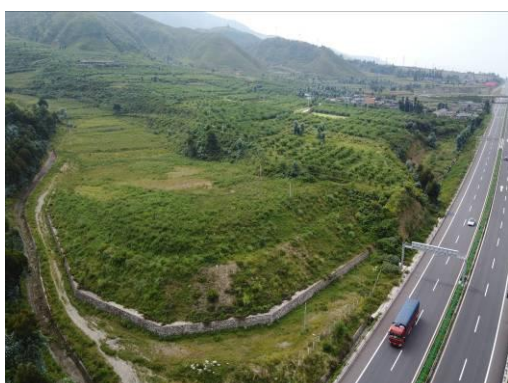
弃渣场挡墙（2020年8月）
