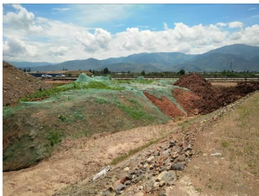
互通工程区临时苫盖（2018年10月）
