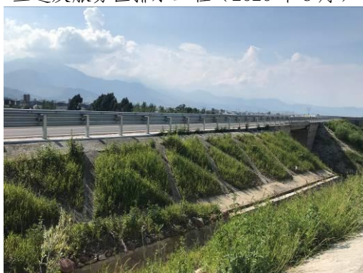
互通及服务区骨架护坡（2020年8月）
