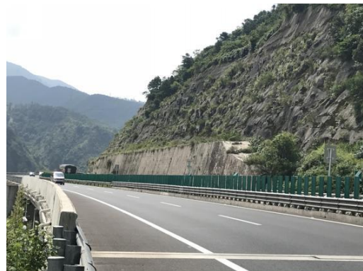
路基工程边坡防护 (2020 年 8 月)
