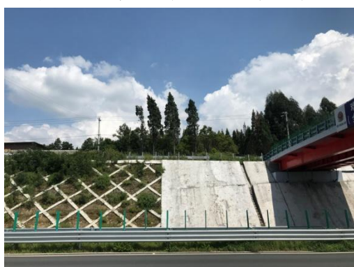
桥梁工程绿化 (2020年8月)
