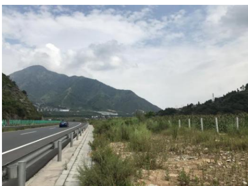
路基工程外侧绿化 (2020年8月)
