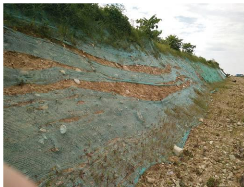
路基工程挖方边坡覆盖（2018年4月）
