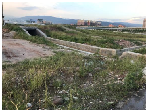
互通及服务区排水工程（2020年8月）
