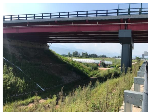
桥梁工程绿化 (2020年8月)
