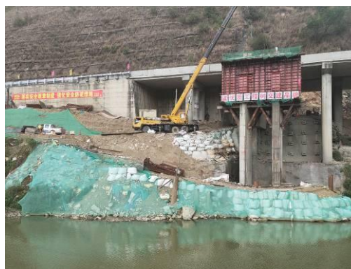
桥梁工程编织袋拦挡（2019年5月）
