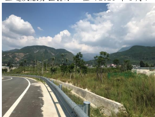
互通及服务区排水工程（2020年8月）
