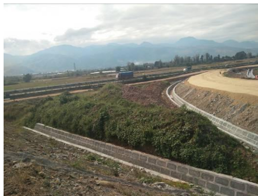
互通工程区排水沟挖方（2018年2月）
