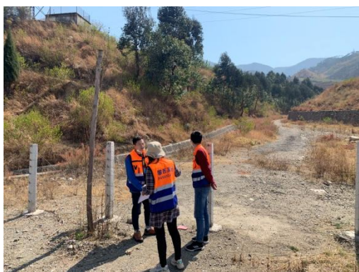
植物措施质量核查（施工便道植被建设）
