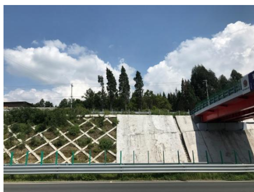
桥梁工程边坡防护（2020年8月）
