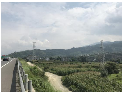
路基工程下边坡绿化 (2020年8月)
