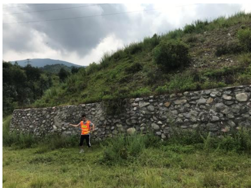
工程措施质量核查（挡渣墙）
