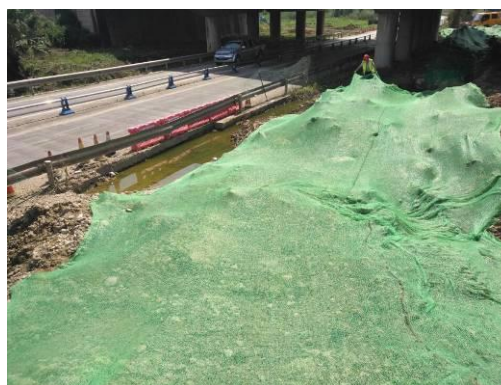
桥梁工程施工边坡覆盖（2018年5月）
