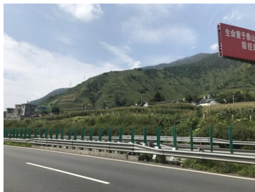
路基工程边坡植被恢复 (2020年8月)
