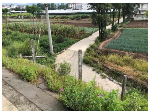
桥梁工程涵洞边坡防护（2020年8月）
