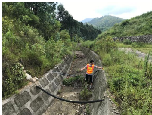
工程措施质量核查（排水沟）
