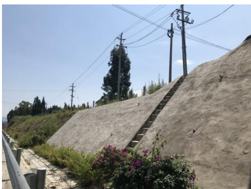
复建道路一侧边坡防护（2020年8月）
