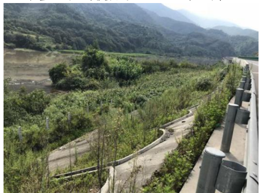
路基工程拱形骨架护坡 (2020 年 8 月)
