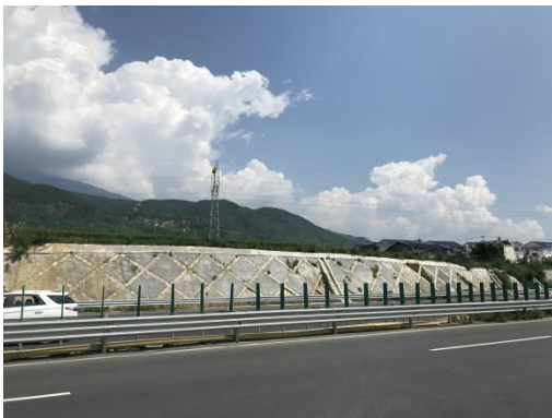
路基工程框格梁护坡 (2020 年 8 月)
