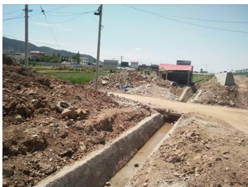
桥梁工程土质排水沟挖方（2018年5月）
