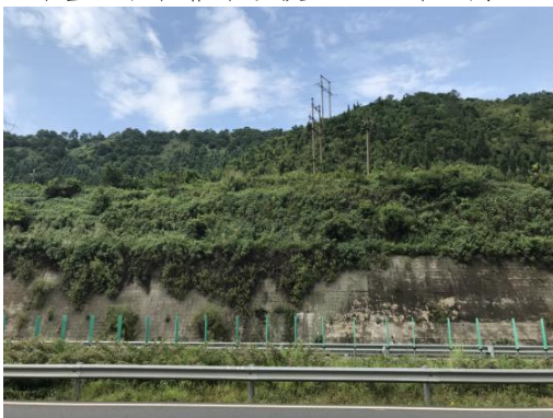
路基工程边坡防护 (2020 年 8 月)
