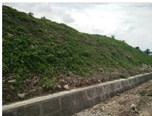
路基工程表土临时防护（2018年5月）
