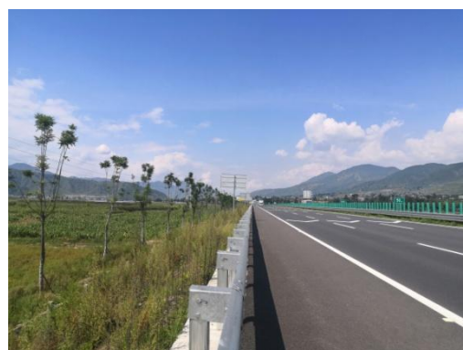
路基工程外侧边坡绿化 (2020年8月)
