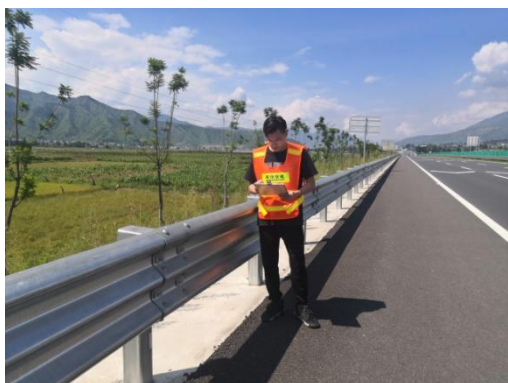
植物措施质量核查（路基边坡植被建设）
