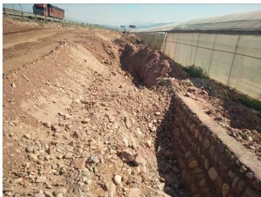
路基工程土质排水沟挖方（2017年4月）
