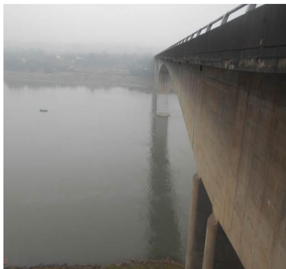
图 3-2 长江二桥现场实景照片
