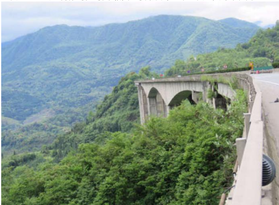
图 1-4 黑石沟特大桥现场实景照片
