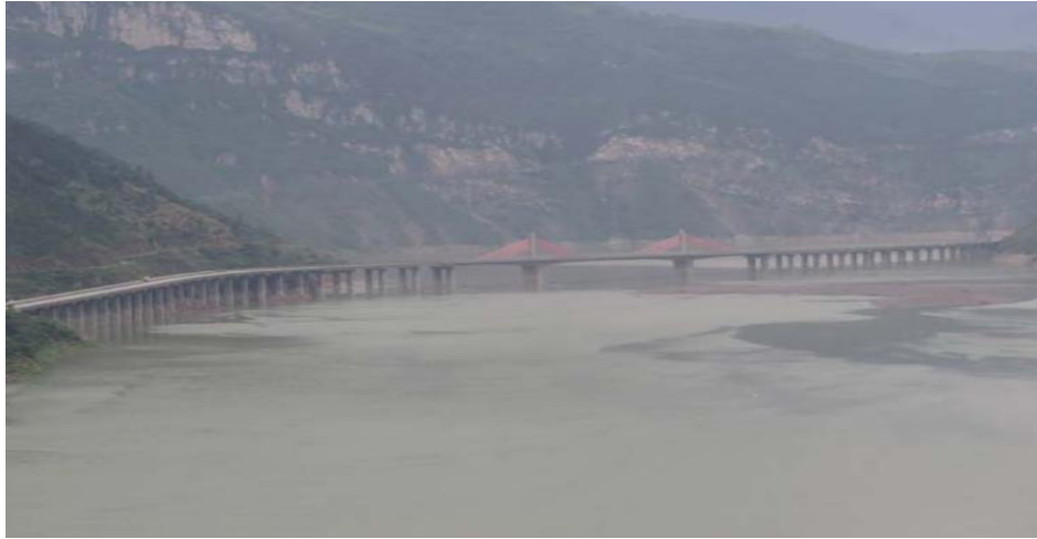
图 2-4 观音岩特大桥现场实景照片
