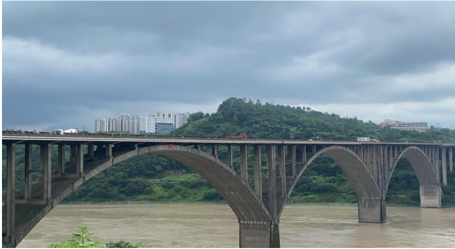
图 6-2 岷江二桥现场实景照片
